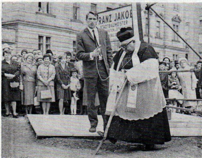
„Endlich“ 21. Mai 1967 8 Uhr früh Spatenstich!
